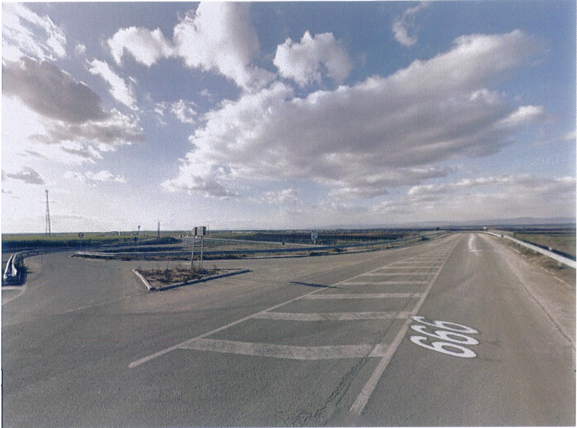
Сн.3. П.в."Плодовитово" – изградената част
